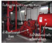
ภาพที่ 6 การขับเคลื่อนเครื่องสูบน้ำดับเพลิงด้วยเครื่องยนต์ดีเซล และมอเตอร์ไฟฟ้า
