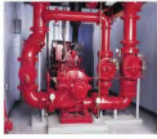
ภาพที่ 4 เครื่องสูบน้ำดับเพลิงชนิดแรงเหวี่ยงหนีศูนย์กลางแบบ Horizontal Split-Case
