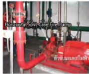
ภาพที่ 6 การขับเคลื่อนเครื่องสูบน้ำดับเพลิงด้วยเครื่องยนต์ดีเซล และมอเตอร์ไฟฟ้า
