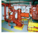
ภาพที่ 5 เครื่องสูบน้ำดับเพลิงแบบ เทอร์ไบน์แบบตั้ง (Vertical Turbine Pump)
